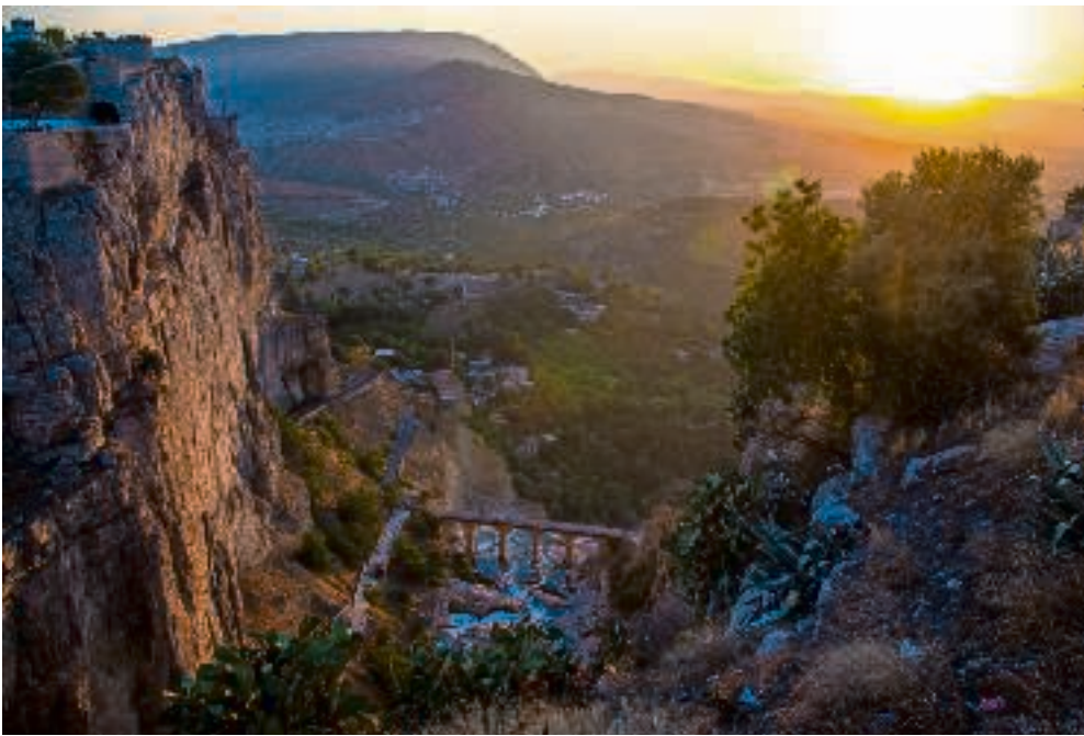
Viadukten i bunden af kløften ved Constantine.
